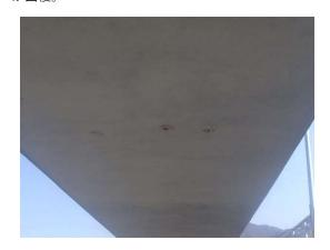
橋脚のひび割れ補修により、健全性が回復。
