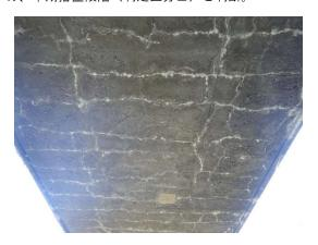
【橋脚】ひび割れから著し漏水や遊離石灰が生じているため、早期措置段階(判定区分Ⅲ)と判断。
