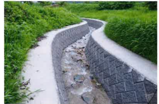
災害復旧工事完了写真
