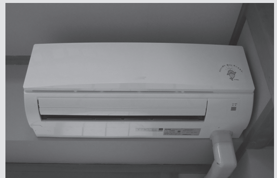
▲整備したエアコン
