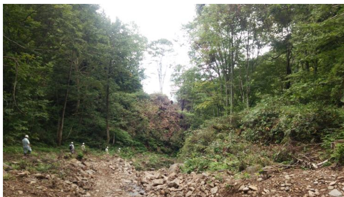
地域・町・県による危険箇所の確認
